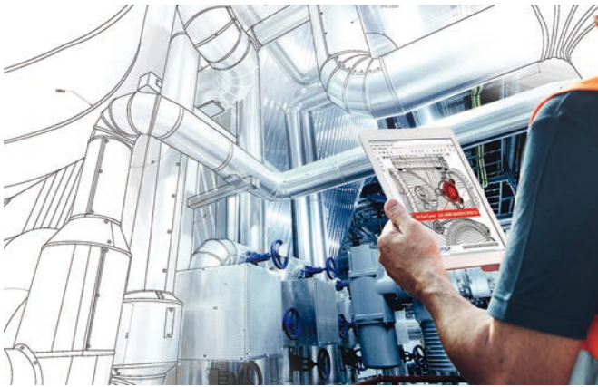
Bild 3 Die Überlagerung der digitalen Abbildung mit der physikalischen und tatsächlichen Anmutung führt zur Dokumentation des As-built-Zustands Augmenting physical and natural appearance with digital images leads to documentation of as built configuration
